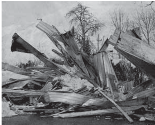
Abb. 5: Überreste der eingestürzten Eissporthalle von Bad Reichenhall Anfang Januar 2006.
